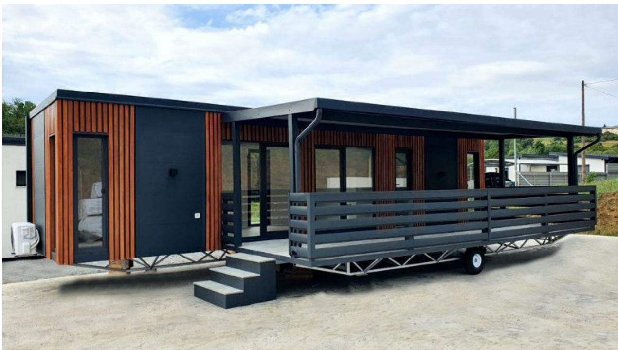
Prednja strana sa terasom pogled 1
